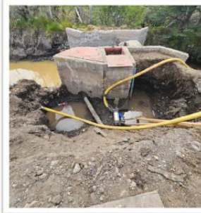
OBRAS EN LA CAPTACIÓN
