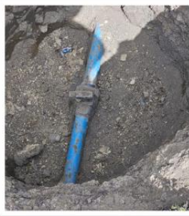
OBRAS EN LA ADUCCIÓN
