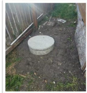
OBRAS EN LA RED DE DISTRIBUCIÓN
