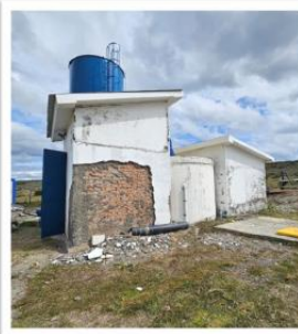
OBRAS PLANTA DE TRATAMIENTO / ESTANQUES
